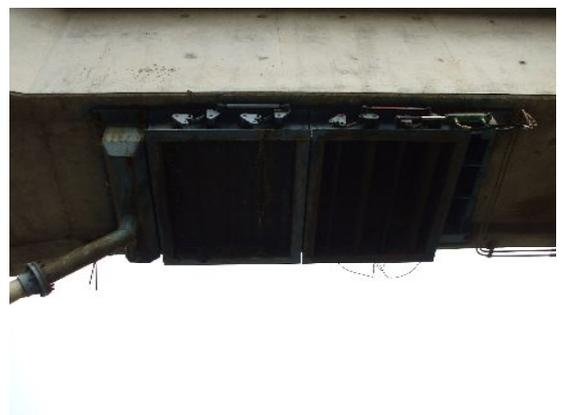
図13 空気の排気口(左), 吸気口(右)
