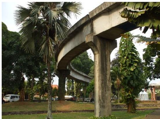
図2 コンクリート製橋脚(高さ6m, 幅0.7m)
