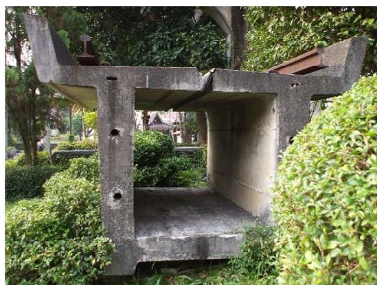
図3 コンクリート製矩形パイプライン
