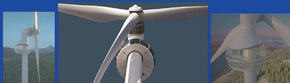
展望室付き風車／the Eye of the Wind／バンクーバー、カナダ／1500kW、ハブ高さ65m、翼直径77m
