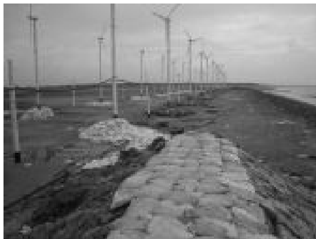
図 4 Kutubdia の風車群と被害を受けた岸壁
